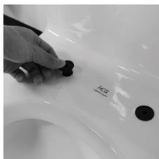
取膨脹螺絲組，依圖示置入馬桶蓋安裝孔內，並將其壓至定位。
