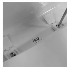
先行將固定座稍微鎖緊後，再調整馬桶蓋組與馬桶邊緣切齊。
