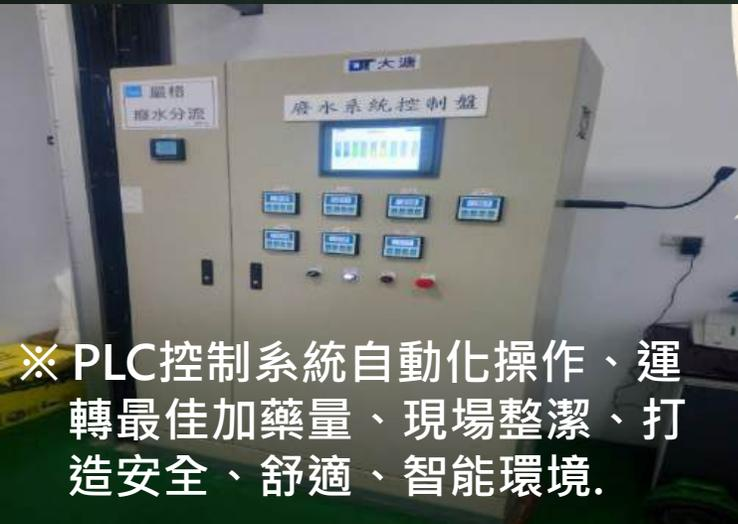
※ PLC控制系統自動化操作、運轉最佳加藥量、現場整潔、打造安全、舒適、智能環境。
